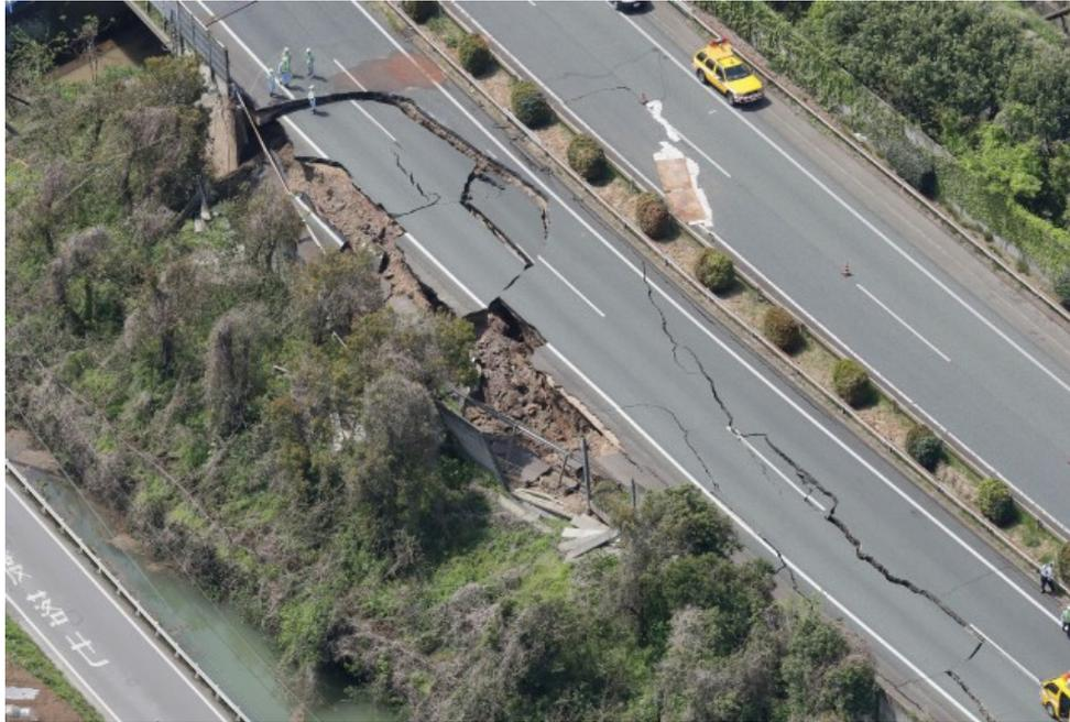
Abb. 3.2 Versagen einer Böschung beim Erdbeben von Kumamoto in Japan (Magnitude 7.0, 2016).
