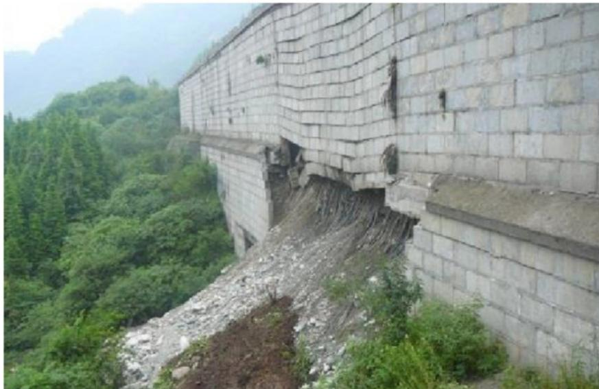
Abb. 3.4 Versagen einer Stützmauer beim Erdbeben von Wenchuan in China (Magnitude 7,0, 2008)
